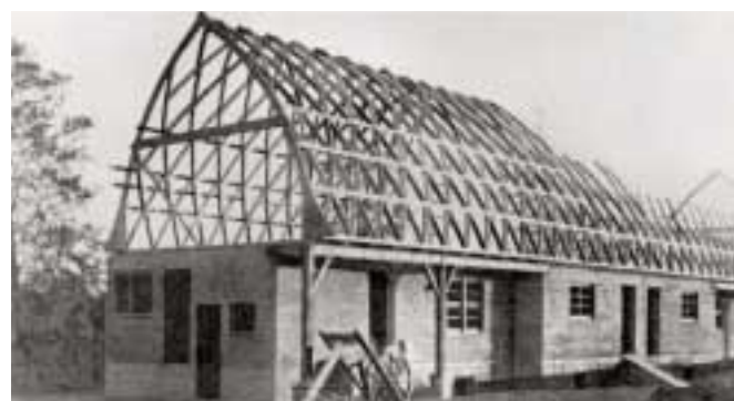
4 Lamellendach eines Einfamilienhauses mit Walm und eingebauter Zwischendecke
